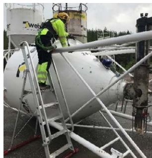
10. Aseta nostolenkit siilon kyljessä olevaan nostokorvakkeeseen.
