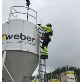
6. Laskeudu siilon päältä käyttäen putoamissuojausta.
