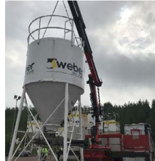
7. Asemoi siilo vapaaseen tilaan kyljelleen laskua varten.
