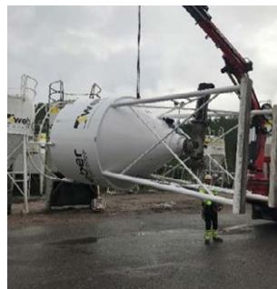
11. Nosta ja siirrä siilo rauhallisesti ajoneuvon lavan päälle. Mikäli siilo ei nostettaessa ole tasapainossa, aseta toinen nostolenkki kannen nostokorvakkeeseen ja hae ketjujen pituuksilla tasapainopiste siilolle.
