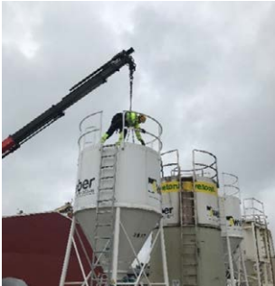
5. Aseta nostolenkit siilon kannella sijaitseviin kahteen nostokorvakkeeseen.
