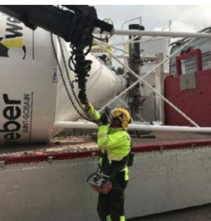
13. Irrota nostoketju nosturista. Sido siilo huolellisesti kiinni ajoneuvoon.
