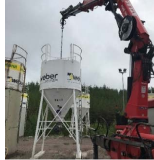
3. Aseta puomi valmiiksi nostoketjuineen keskelle siilon päälle.
