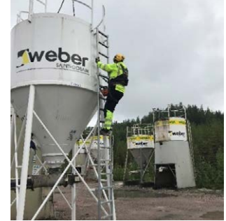
4. Kiipeä siilon kannelle käyttäen putoamissuojausta. Katso erillinen kiipeämisohje.
