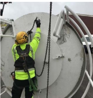
9. Irrota nostolenkit siilon nostokorvakkeista.
