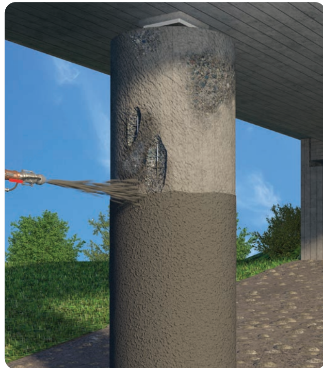
Betonin korjaaminen
