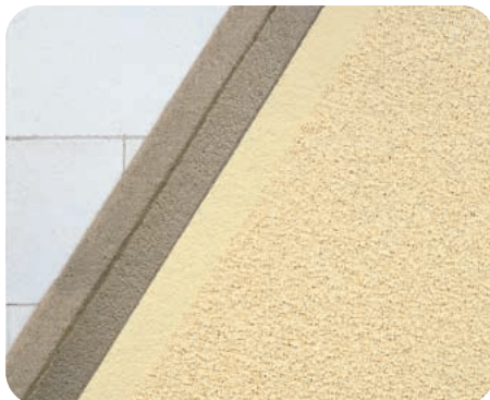
KUVA 25. Kaksikerrosrappaus, rakennekerrokset
