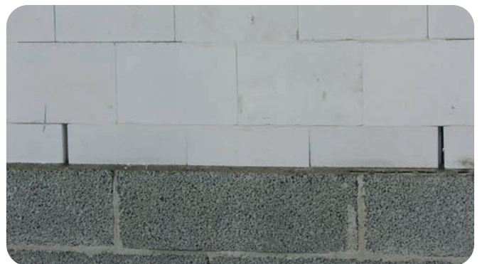
KUVA 23. Kuorimuurin liitos sokkeliin
