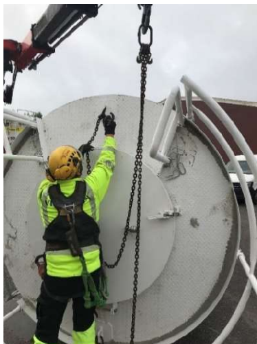
7. Kiinnitä nosturin nostolenkit siilon kannen kahteen nostokorvakkeeseen.
