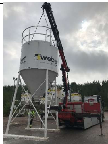
9. Siirrä siilo nosturilla haluttuun sijaantiin. Huomioi erillinen pystytysohje.
