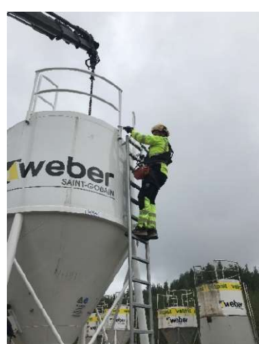
12. Laskeudu alas siilon päältä käyttäen putoamissuojausta.
