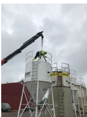
11. Irrota nosturin nostolenkit siilon nostokorvakkeista.
