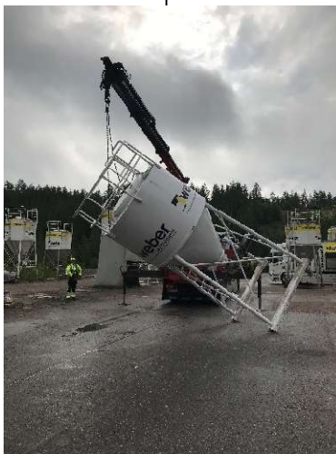
8. Nosta siilo rauhallisesti pystyasentoon.
