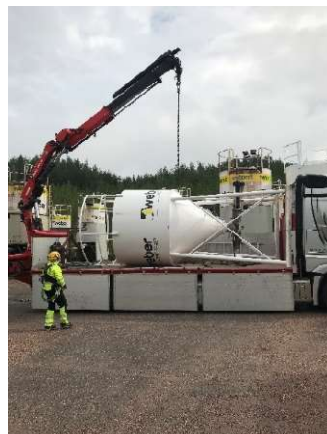
12. Laske siilo varovast ajoneuvon lavalle.
