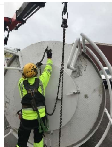
9. Irrota nostolenkit siilon nostokorvakkeista.
