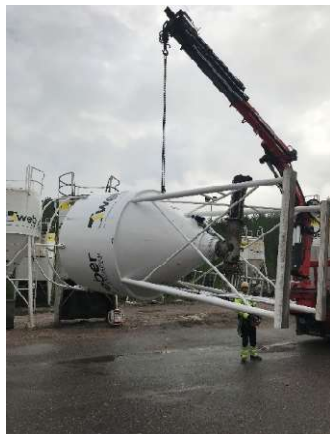
11. Nosta ja siirrä siilo rauhallisesti ajoneuvo lavan päälle
