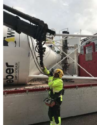
13. Irrota nostoketju nosturista. Sido siilo huolellisesti kiinni ajoneuvoon.
