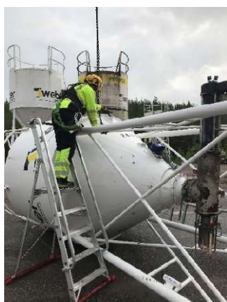
10. Aseta nostolenkit siilon kyljessä olevaan nostokorvakkeeseen.
