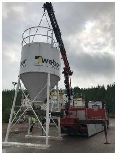
7. Asemoi siilo vapaaseen tilaan kyljelleen laskua varten.
