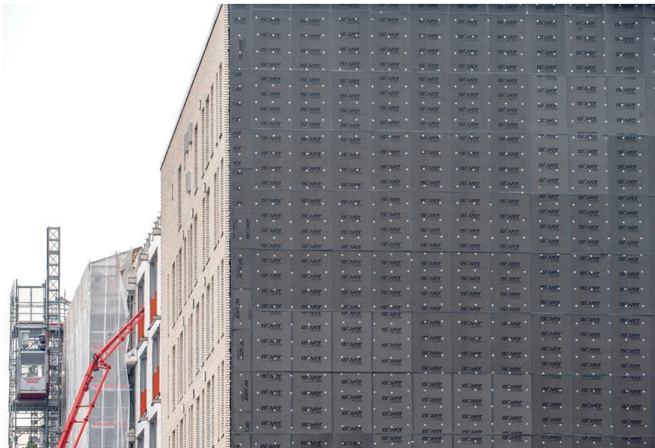
KUVA 24. Kahi Facade -julkisivurakenteen toimivuus on testattu taulukossa 24 mainituilla laasteilla. Rakenne on läpäissyt vaativan 100 kierroksen jäädytys-sulatustestin.
