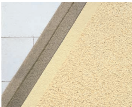
KUVA 25. Kaksikerrosrappaus, rakennekerrokset
