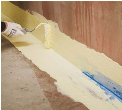
Telaa WX Vedeneristettä nauhan päälle.
