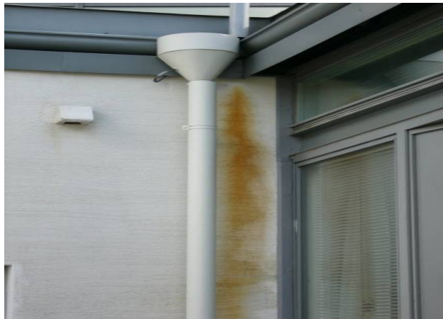
Kuva 1. Tukkeutunut syöksytorvi
