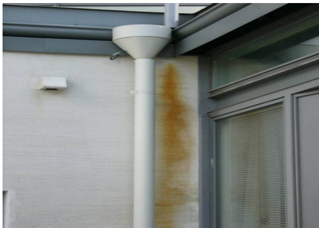
Kuva 1. Tukkeutunut syöksytorvi
