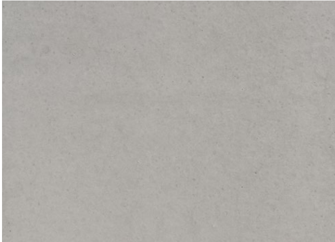
Betonialusta ennen pinnoitusta.
