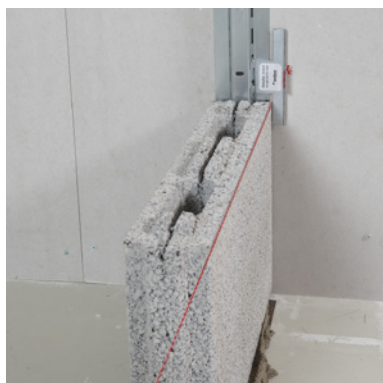
Leca EasyLex 2500 profiili kiinnitetään seinään. Profiiliin asennetaan langanohjain ja linjalanka. Ensimmäinen harkkokerros muurataan ohutsaumatai muurauslastilla.
