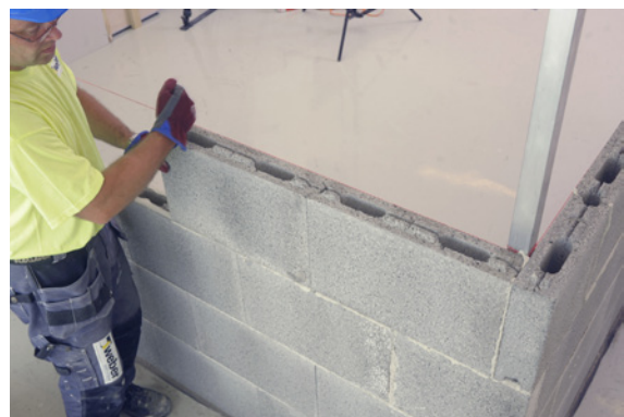
Ulkokulmissa käytetään toisesta päästäan ponttaamatonta päätyharkkoa, jolloin kulmista tulee siistit.
