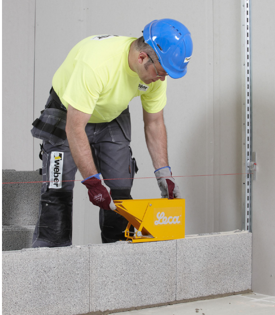
webervetonit OL 15 Ohutsaumalaasti on helppo ja nopea levittää ohutsaumakelkan avulla.
