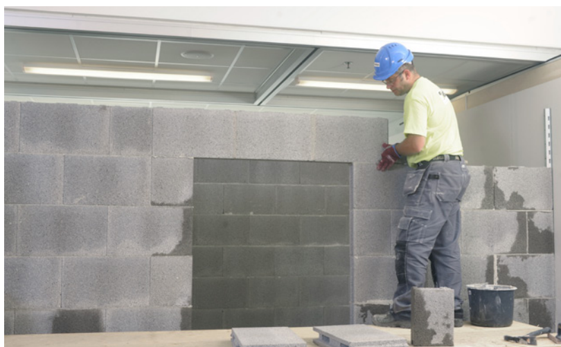
Leca EasyLex 2500 profiili kiinnitetään seinään. Profiiliin asennetaan langanohjain ja linjalanka. Ensimmäinen harkkokerros muurataan ohutsaumatai muurauslastilla.
