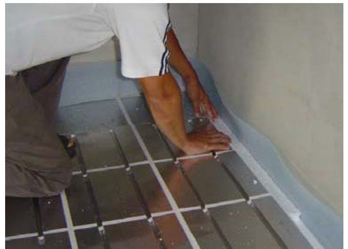
Reunanauhan ja Comfort Lämpölattialevyjien asentaminen.
