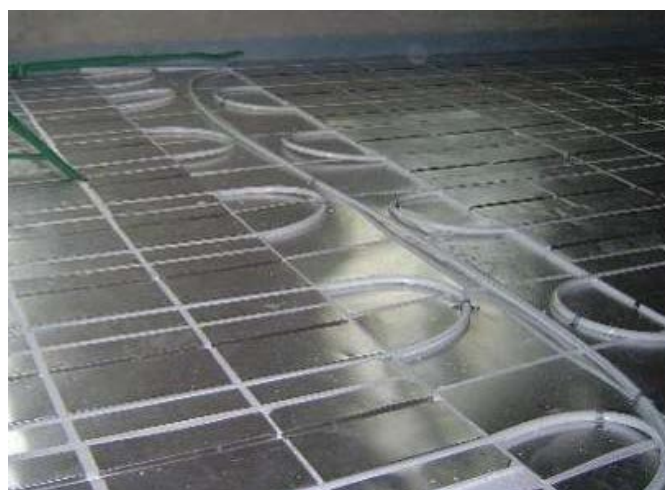
Kääntölevyn asennusperiaate.
