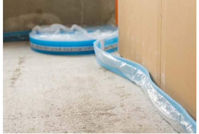
weberfloor 4960 Reunanauhan asennus.
