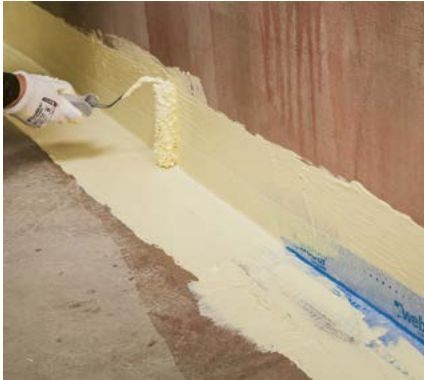
Telaa WX Vedeneristettä nauhan päälle.
